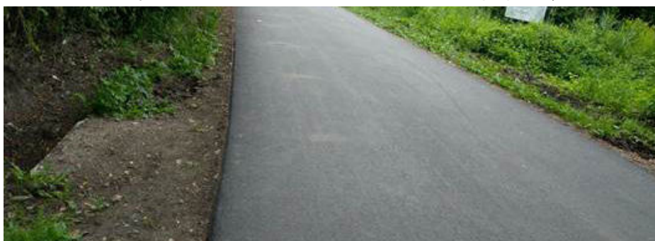
Remont ścieżki pieszo-rowerowej na Zakrzówku, fot. Elżbieta Pytlarz
