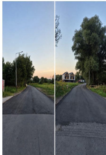
Ul. Działowskiego - remont nawierzchni jezdni, fot. Gabriela Głownia
