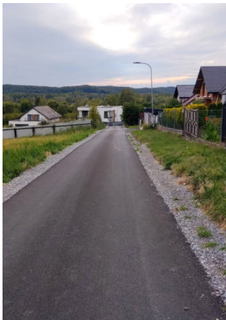
Ul. Hufcowa - remont nawierzchni jezdni, fot. Sławomir Siekacz
