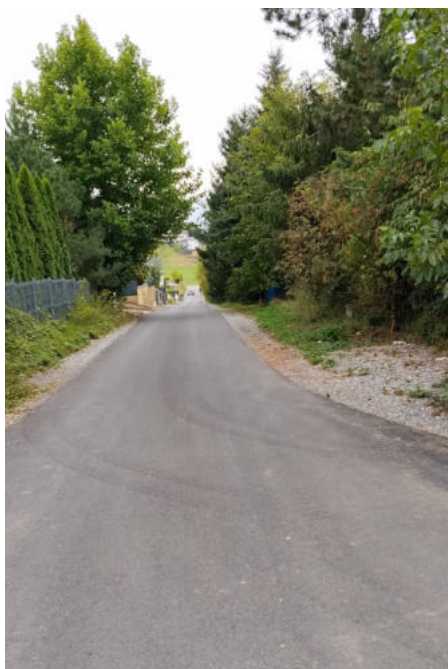
Ul. Grzegorzewskiej - remont nawierzchni jezdni, fot. Sławomir Siekacz
