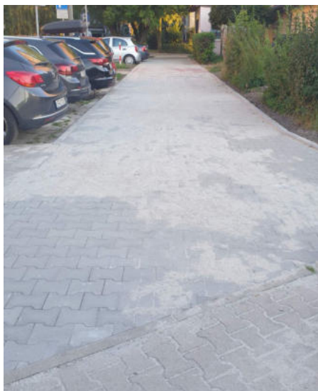
Ul. Grota-Roweckiego 37a, 37b - remont chodnika, fot. Halina Mikołajska
