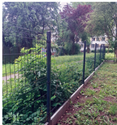
Samorządowe Przedszkole nr 140 - wymiana ogrodzenia, fot. z archiwum Samorządowego Przedszkola nr 140
