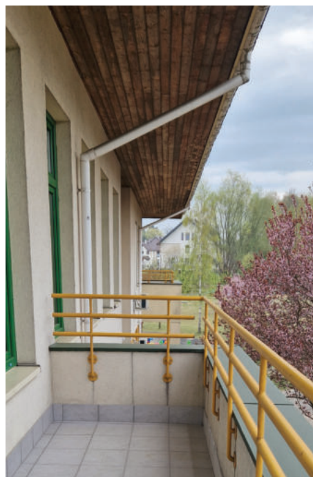
Samorządowe Przedszkole nr 58 - remont płytek i obróbek malarskich na balkonach - kontynuacja, fot. Urszula Twardzik
