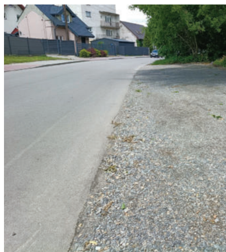
ul. Sodowa - utwardzenie pobocza, fot. Damian Kozłowski
