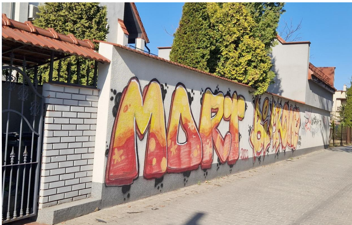
Mur przy Publicznym Przedszkolu w Krakowie, ul. Liściasta 6
