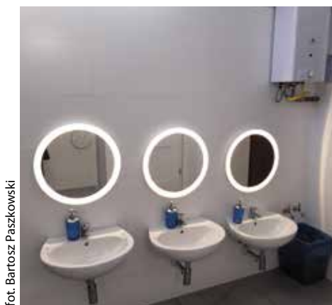
Remont sanitariatu w Samorządowym Przedszkolu nr 67 – filia
