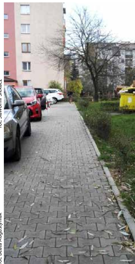
Ul. Grota Roweckiego 51A – remont chodnika
