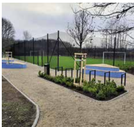
Zielony ogród do gier sportowych i zabaw przy ul. Zakrzowieckiej – budowa
